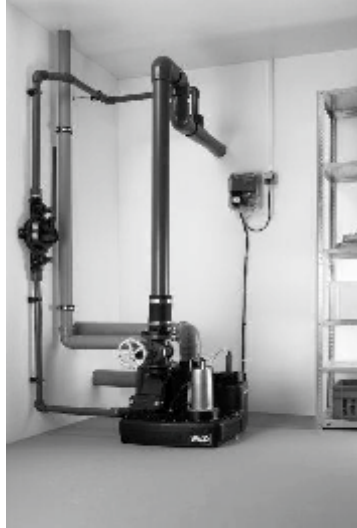
Приклад прокладання трубопроводу вище рівня зворотного підпору
